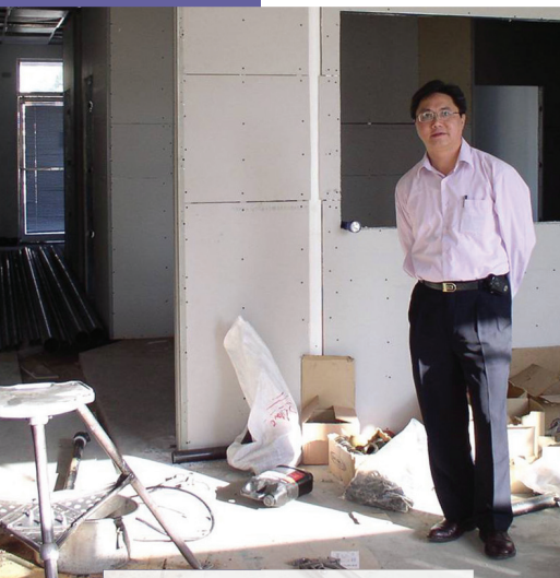
得到神的印證後，醫療中心籌備工作全力進行。施工期間，李偉強牧師常到現場視察。
